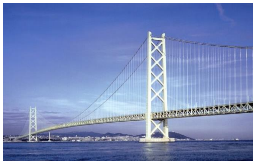
吊橋（明石海峡大橋）
