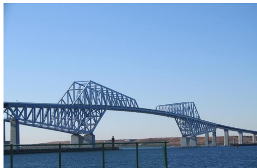
トラス橋（ゲートブリッジ）
