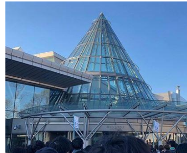
札幌道立体育センター
