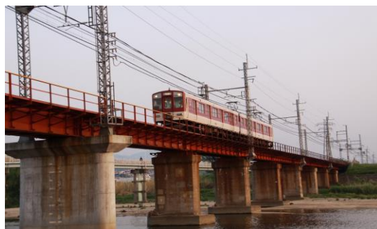
近鉄大和川橋梁
