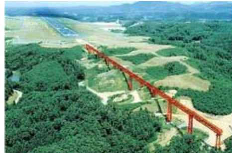
空港進入灯（福島空港）
