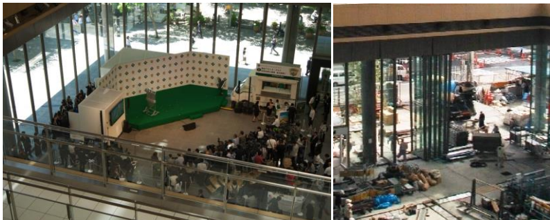
丸の内ビル・ホール非常用大型ドア
